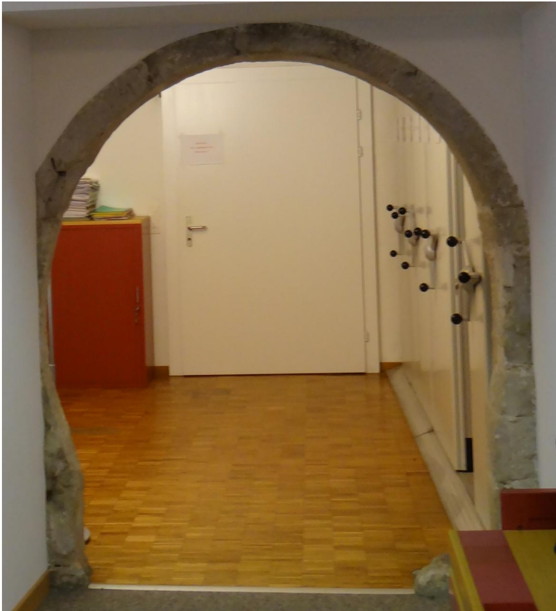
Abb.11. Das Portal zwischen Königshof und Oekonomiegebäude ist effektiv ein Durchbruch durch die Stadtmauer. Vergleiche mit Abb. 10 (archäologischer Stadtplan)
